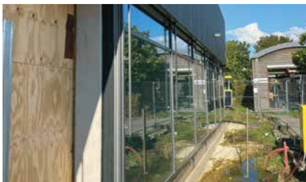
Noch ist es eine Baustelle, demnächst ein energetisch optimiertes Gebäude
